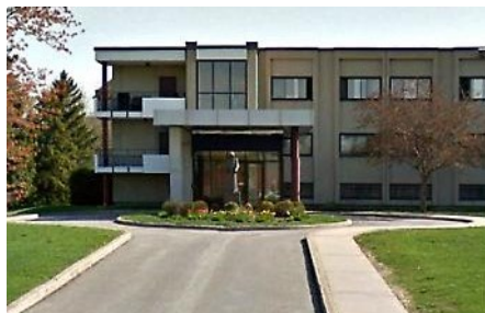
Édifice des Sœurs de la Providence sur Grenet Photo : Ville de Montréal, Juin 2016
